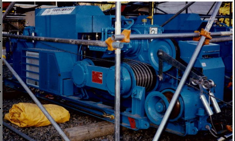
発電機：ウインチ 1台 75kVA以上，2台 125kVA以上
