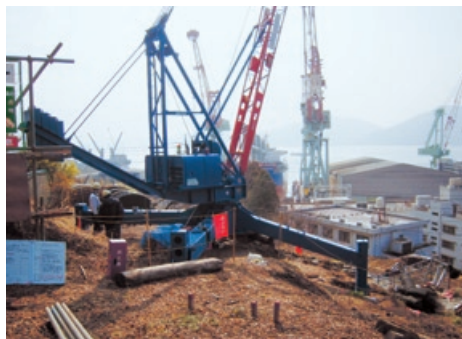
神田造船所線基礎工事（広島県）
