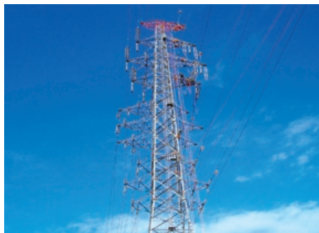
代々崎線電線張替工事（宮城県）
