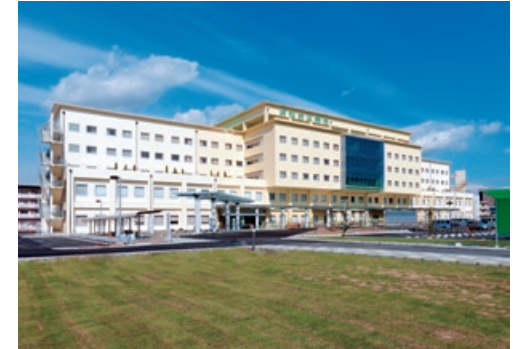
浜松労災病院本館電気設備（通信）工事
