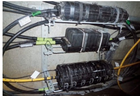
札幌開発建設部管内 光ケーブル移設外一連工事
