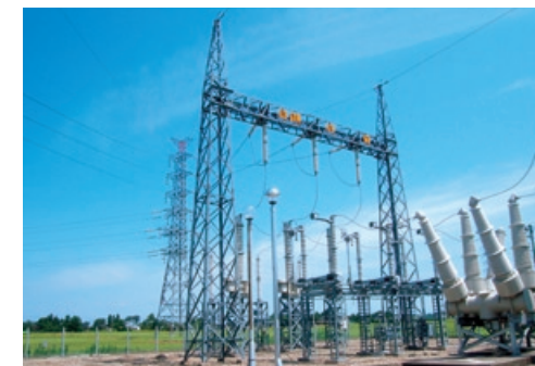
上越幹中之口変電所機器更新工事
