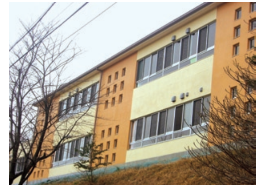
新知保育園園舎電気設備工事（愛知県）
