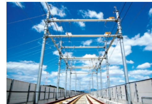
九州新幹線（鹿児島）電車線路工事
