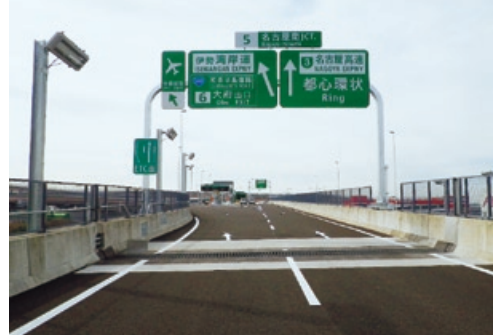
東名阪自動車道 鳴海～名古屋南間標識工事
