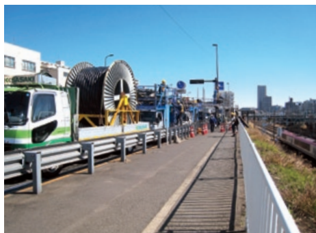
新鶴見～横浜間地中送電線路取替工事
