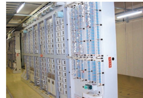
上越幹熊谷駅信号設備新設他工事
